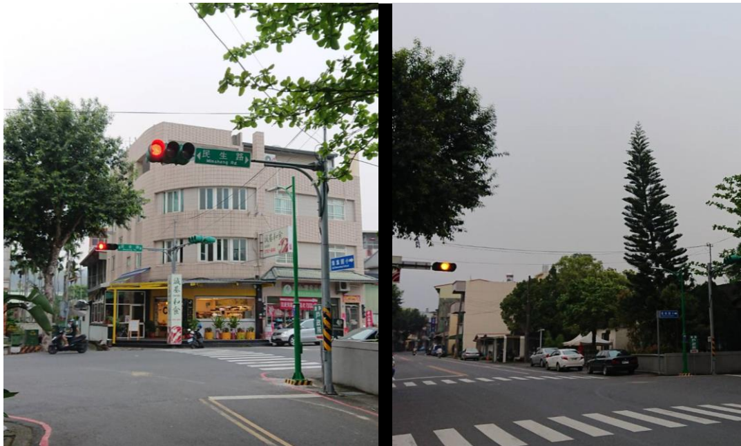
改善後-台電施工通電啟用號誌燈，閃爍紅黃燈警示，提醒用路人經過該路口須減速。
